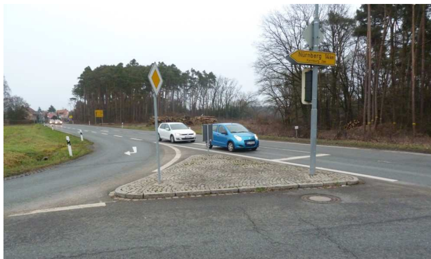
Bestehende Einmündung St 2406/St 2239
